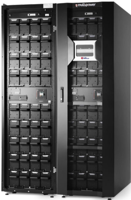
Batterieschrank mit offener und geschlossener Türe.
