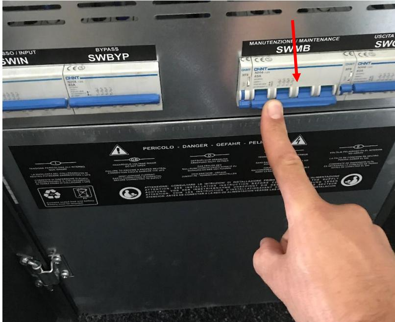
Die angeschlossene Last wird jetzt über die USV Anlage versorgt.
