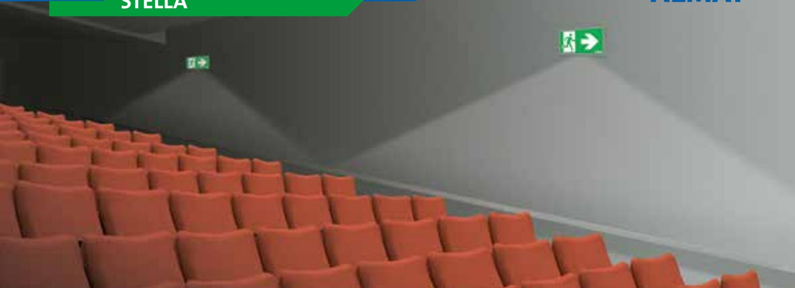
Im Normalbetrieb gedimmt und unauffällig – im Notfall Hinweis und Aufhellung des Fluchtweges durch die STELLA Leuchtscheibe
