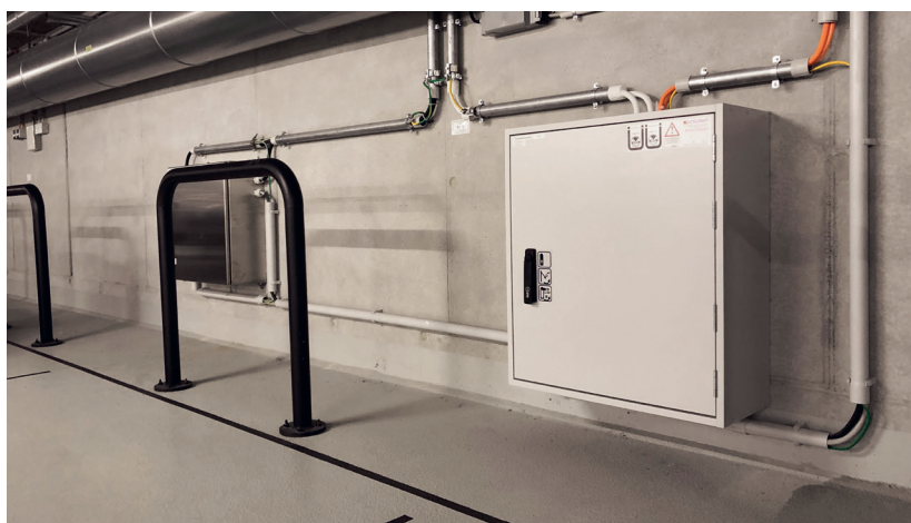
Der EI30 Wandschrank FWE kann einen feuerbeständigen Betriebsraum ersetzen und bietet Sicherheit auf kleinstem Raum.
