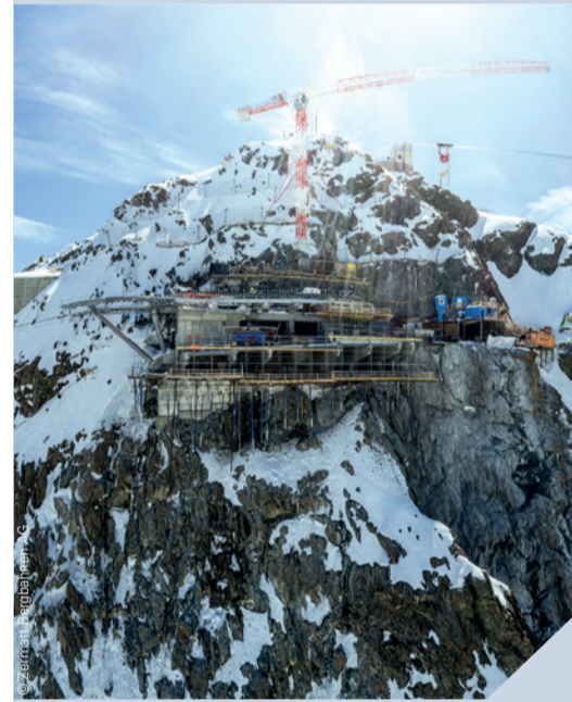
An der Westflanke des Matterhorn glacier paradise (Klein Matterhorn) entsteht die Bergstation 3S.
